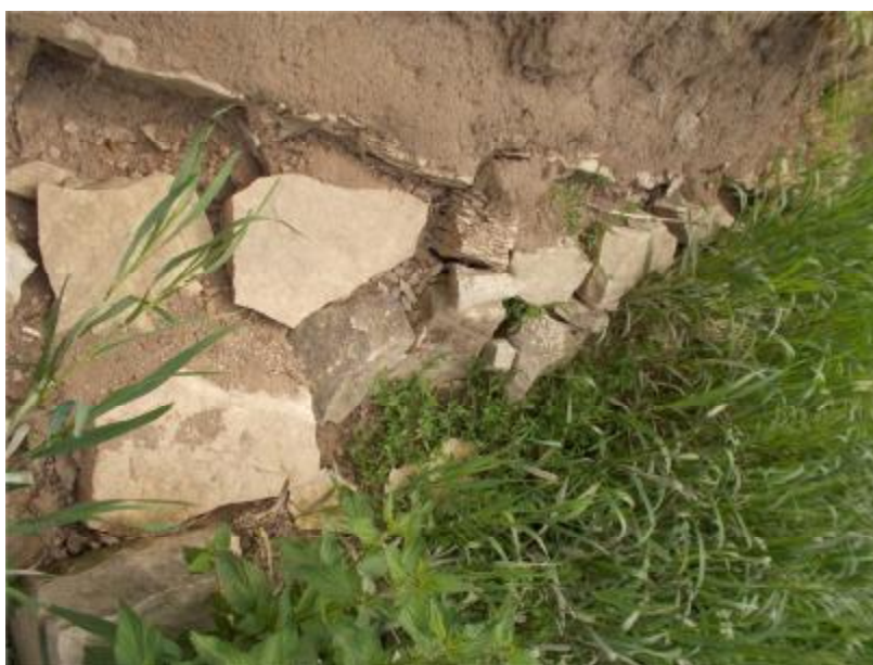
Nevhodný materiál stávající dlažby
