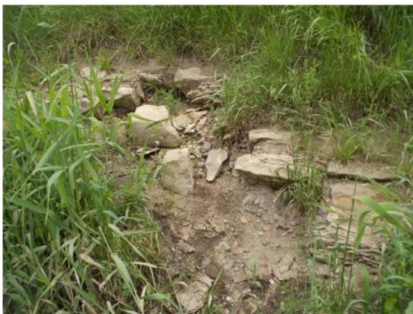
Nevhodný materiál stávající dlažby
